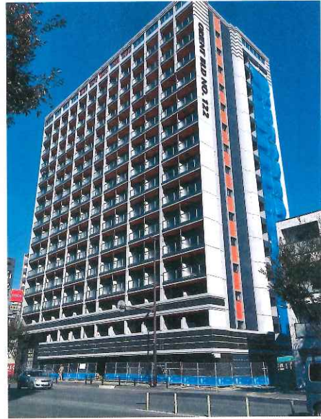
クラブオリエンビルNo.122福岡日赤通り (福岡市、RC15階全208戸) 2018年11月完成
